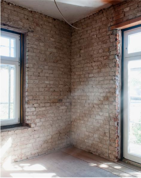
Die Außen- und Innenwände wurden bis auf das rohe Mauerwerk zurückgebaut.
