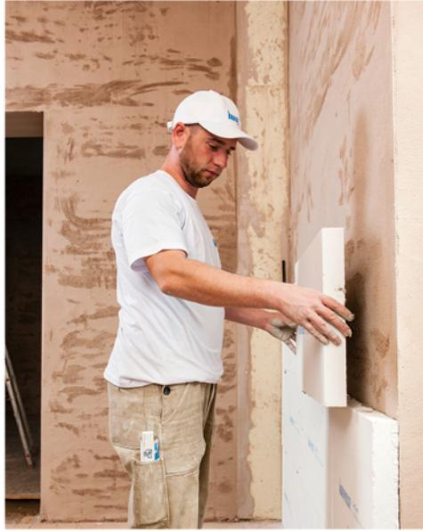
Die kapillaraktive Innendämmung aus Perlite-Dämmplatten misst eine Dicke von 50 mm.
