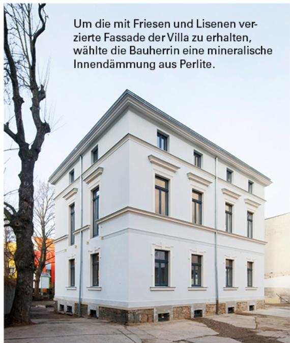
Um die mit Friesen und Lisenen verzierte Fassade der Villa zu erhalten, wählte die Bauherrin eine mineralische Innendämmung aus Perlite.
