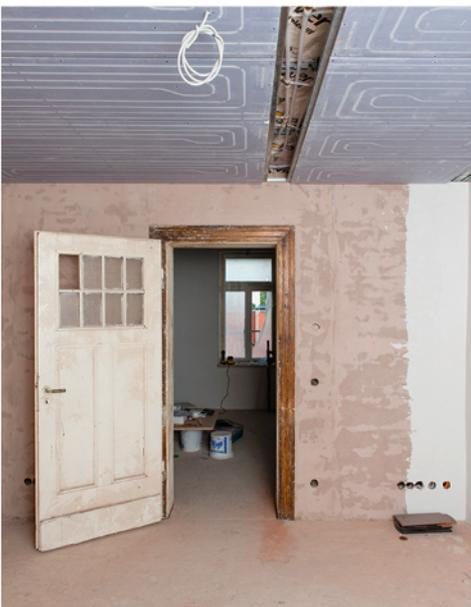
Für die Deckenheizung wählte die Bauherrin das System Renovis von Uponor.
