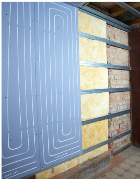
Die Rohre der Uponor-Flächenheizung sind in Trockenbauplatten von Knauf integriert.
