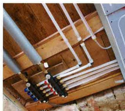
Die Trockenbaulösung Renovis bietet ein Komplettprogramm mit kompakten Pumpengruppen, Raumfühlern und Verteilern an.
