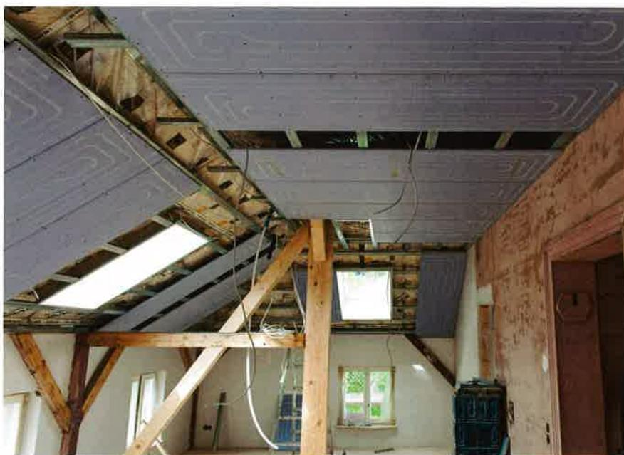
Deckenheizung im Dachgeschoss: Die aufgedruckte Verlegung der Rohre erleichtert den Einbau von Einbauleuchten, Luftauslässen oder Sprinklern.
