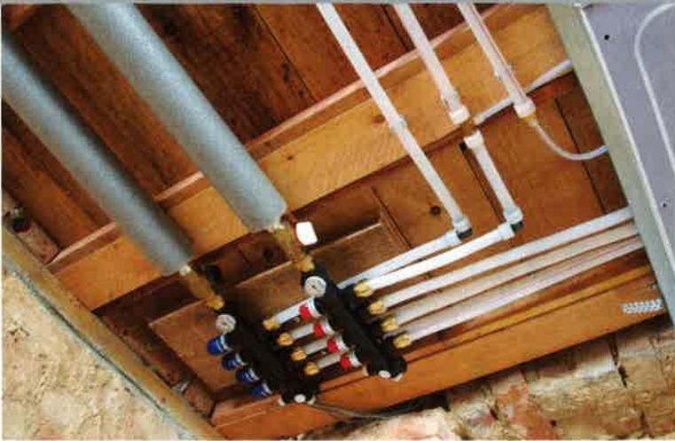
Die Trockenbaulösung von Uponor bietet ein Komplettprogramm mit kompakt zu bauenden Pumpengruppen, Raumfühlern und Verteilern an.
