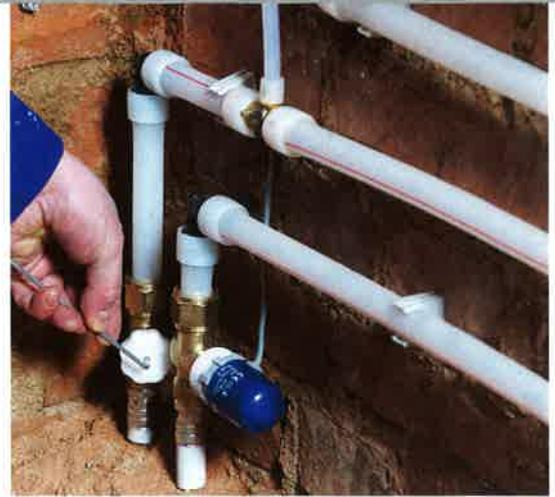
Die PE-Xa-Rohre wurden mit Fittings mit Quick-&-Easy-Technologie verbunden.
