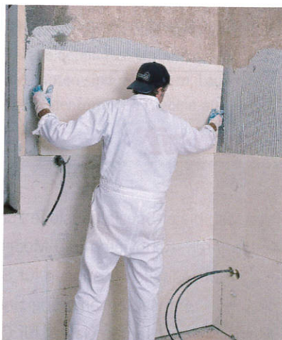
4 Die iQ-Therm-Platten in das frische vollflächige Klebebett eindrücken und ausrichten. Kreuzfugen vermeiden.
