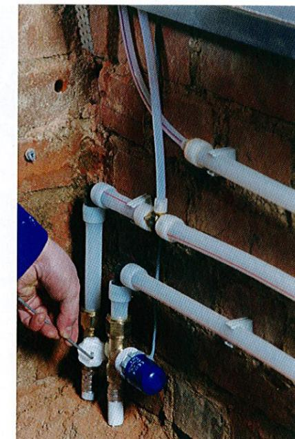
Die PE-Xa-Rohre werden beim Renovis-System mit den Fittings mit Quick & Easy-Technologie verbunden. Das ermöglicht eine schnelle und einfache Montage.
