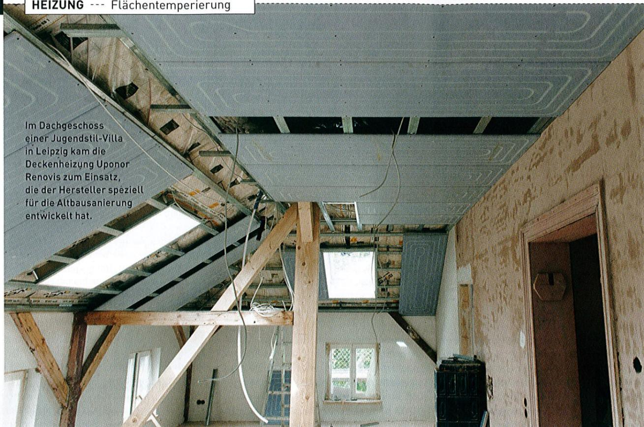
Im Dachgeschoss einer Jugendstil-Villa in Leipzig kam die Deckenheizung Uponor Renovis zum Einsatz, die der Hersteller speziell für die Altbausanierung entwickelt hat.
