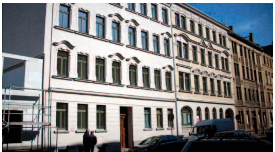
5 Zentimeter IQ-Therm: Oberfläche 18,3, Ecke 18,1 Grad Celsius U-Wert: 0,43 W/m 2 K
